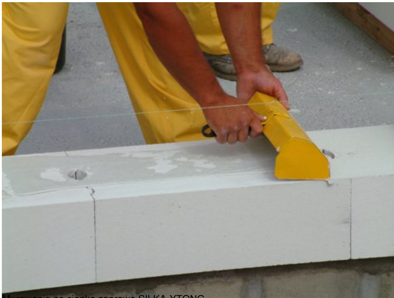
Murowanie na cienką zaprawę SILKA-YTONG
