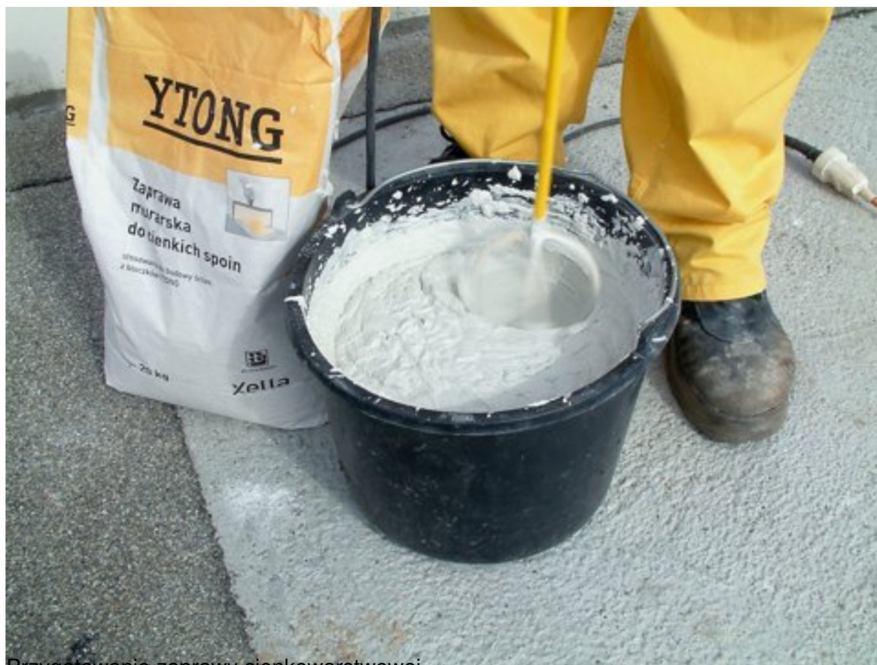
Przygotowanie zaprawy cienkowarstwowej
